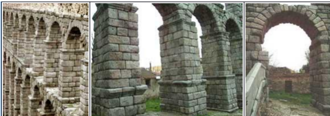
Detalles del acueducto
